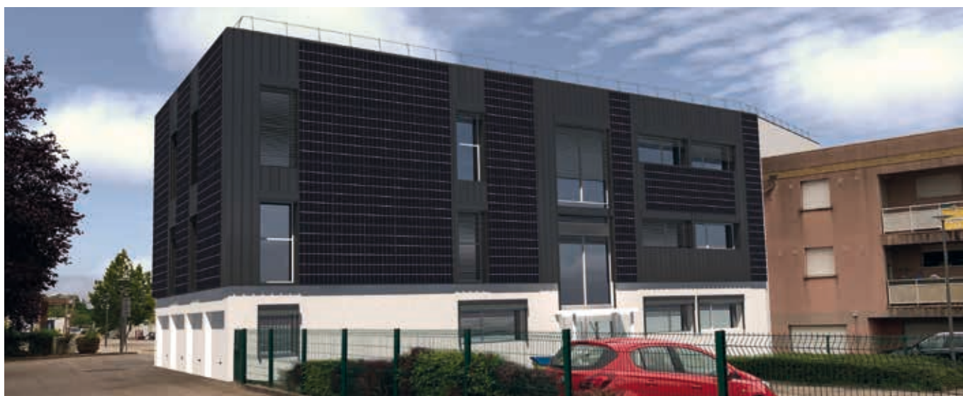
Vue arrière du bâtiment communautaire avec les panneaux photovoltaïques.
